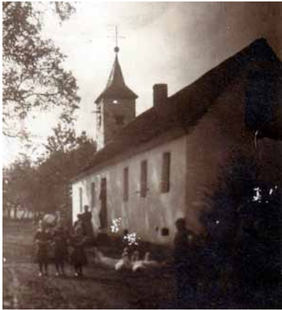
(St. Annenkapelle vor dem Abriss 1960)
